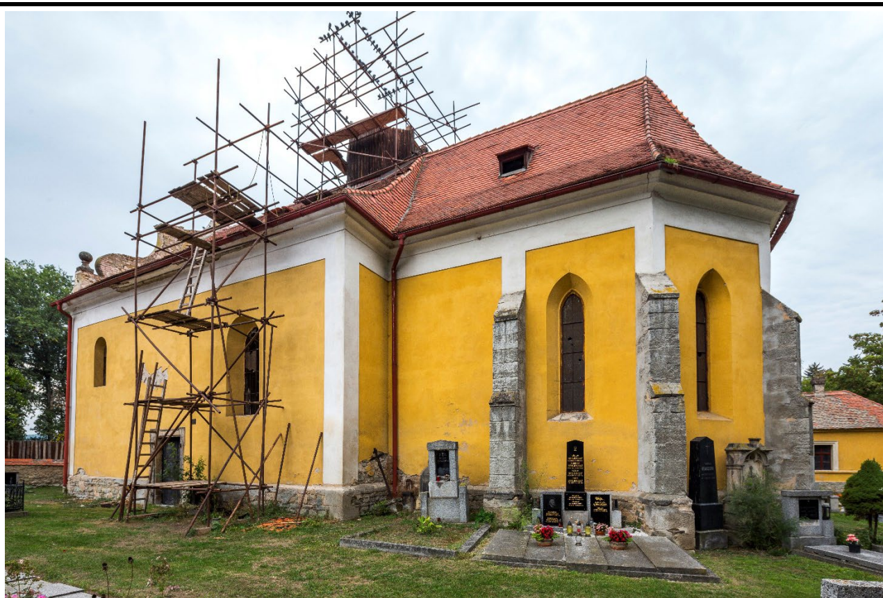
Celkový pohled od jihovýchodu. Foto: Marta Pavlíková, 2018.
