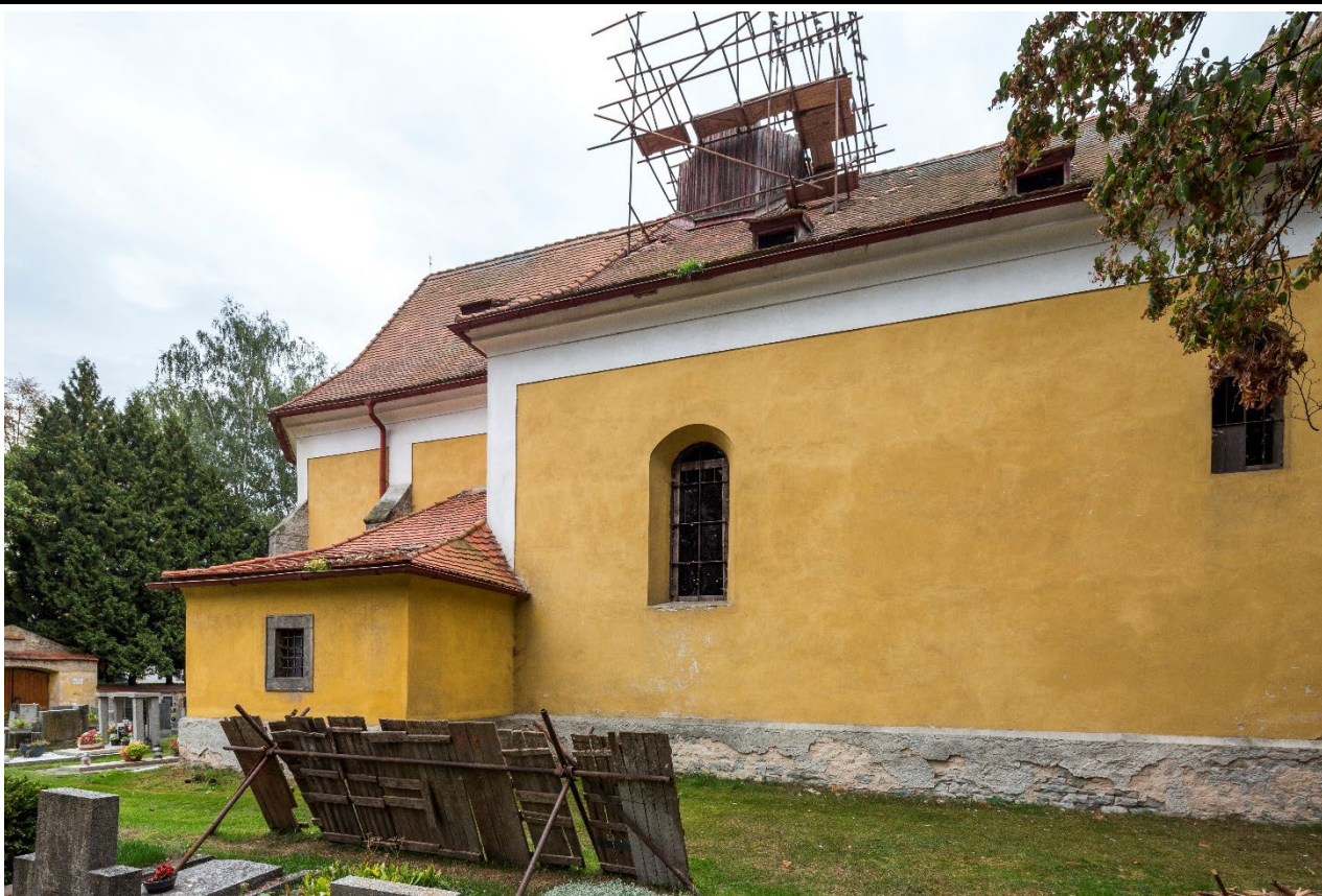
Severní průčelí kostela v pohledu od severu. Foto: Marta Pavlíková, 2018.
