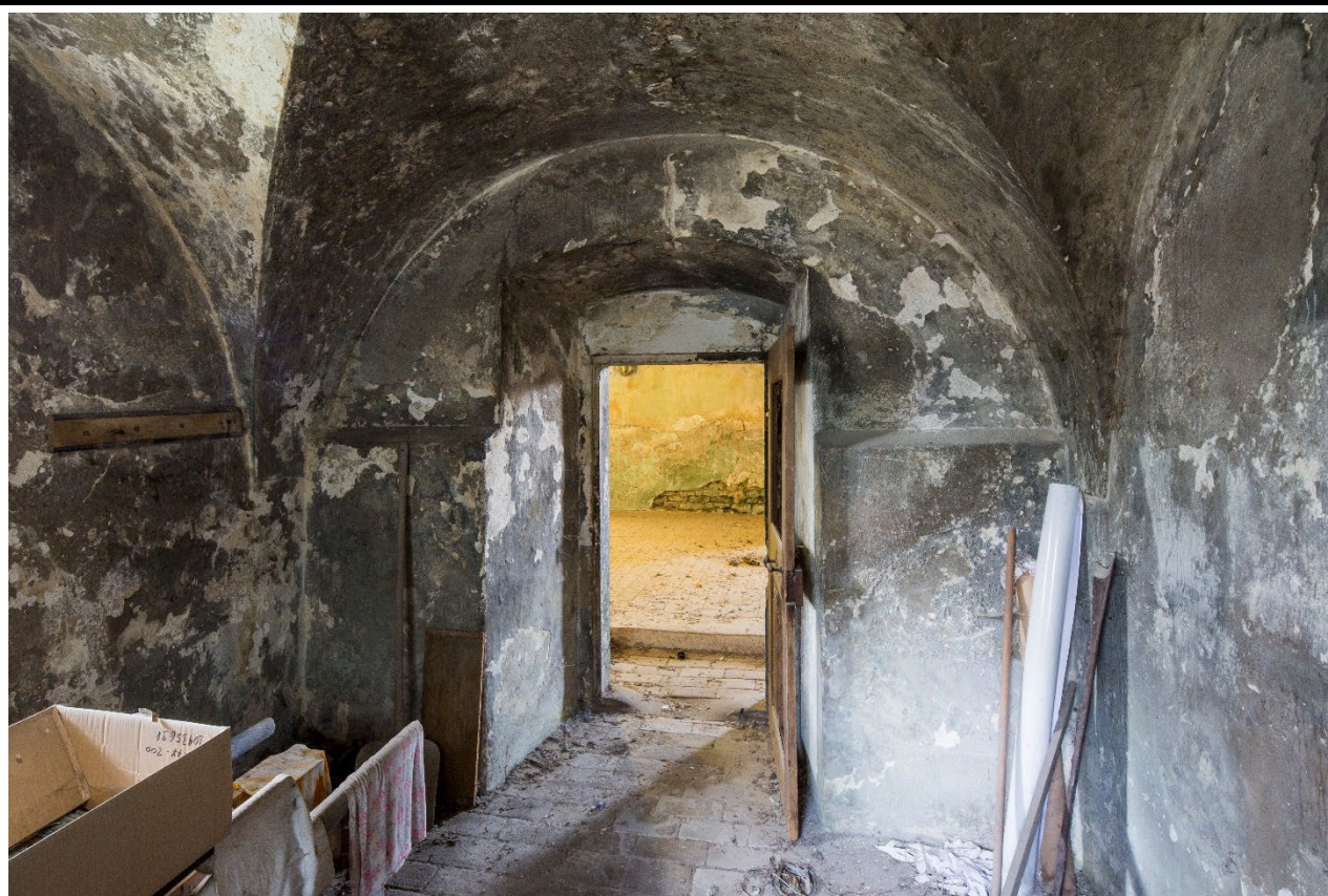
Interiér sakristie v pohledu od severu. Foto: Marta Pavlíková, 2018.
