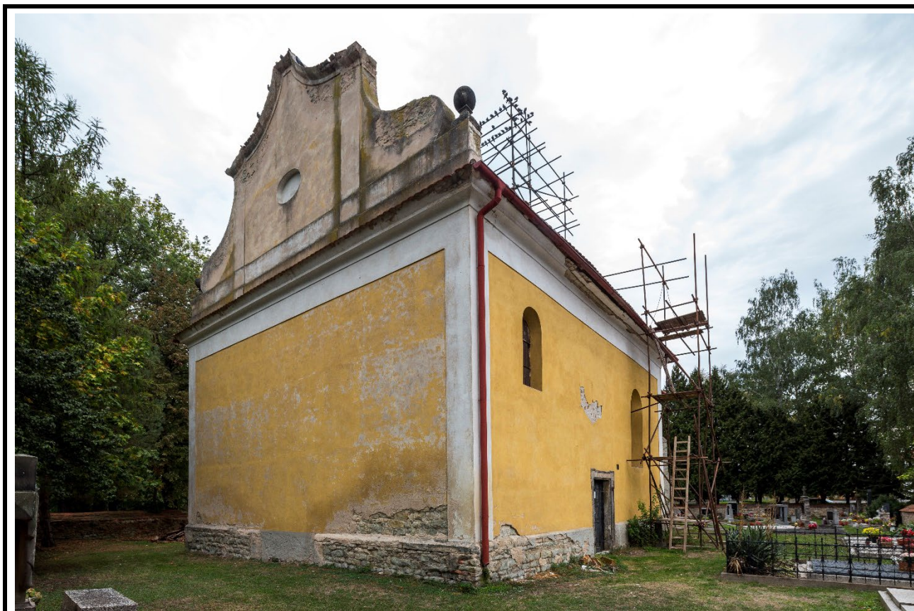
Celkový pohled od jihozápadu. Foto: Marta Pavlíková, 2018.
