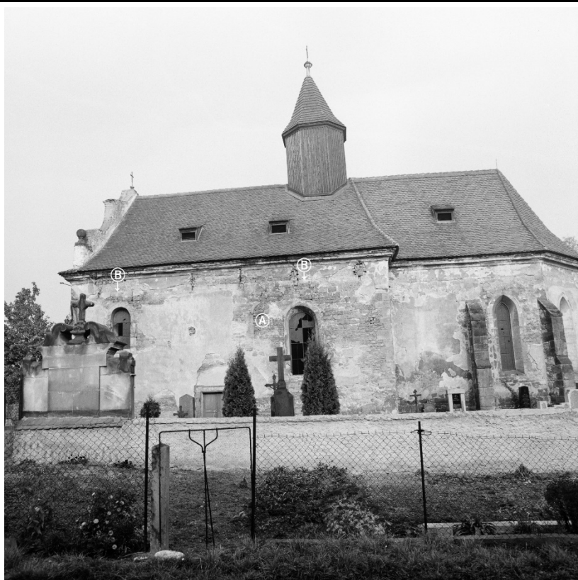
Celkový pohled od jihu na snímku z roku 1987. Zdroj: NPÚ ÚOP v Ústí n. L., Sběrka negativů, sign. 95895. A – Částečně dochované ostění středověkého okenního otvoru. B – Souvislá řada kvádrů náležející patrně někdejší středověké římse.
