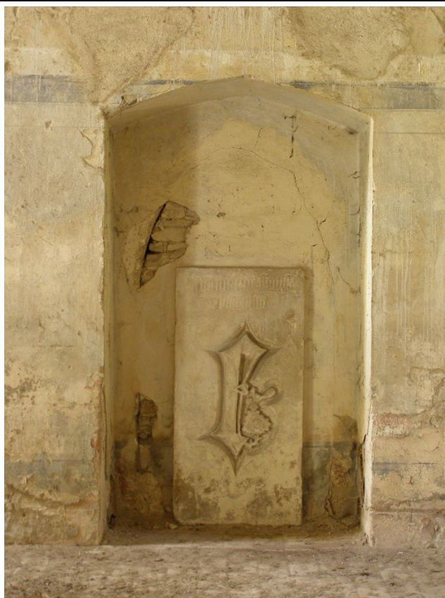
Čelní pohled na niku zazděného západního vstupu lodi s osazeným náhrobkem Elišky z Vršovic a Polenska, která zemřela roku 1474. Foto: Jan Koloc, 2009.
