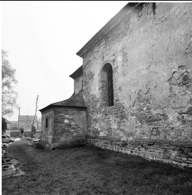
Východní část severní strany lodi a sakristie v pohledu od severozápadu na snímku z roku 1987. Zdroj: NPÚ ÚOP v Ústí n. L., Sběrka negativů, sign. 95900. A – Zazděný středověký okenní otvor.
