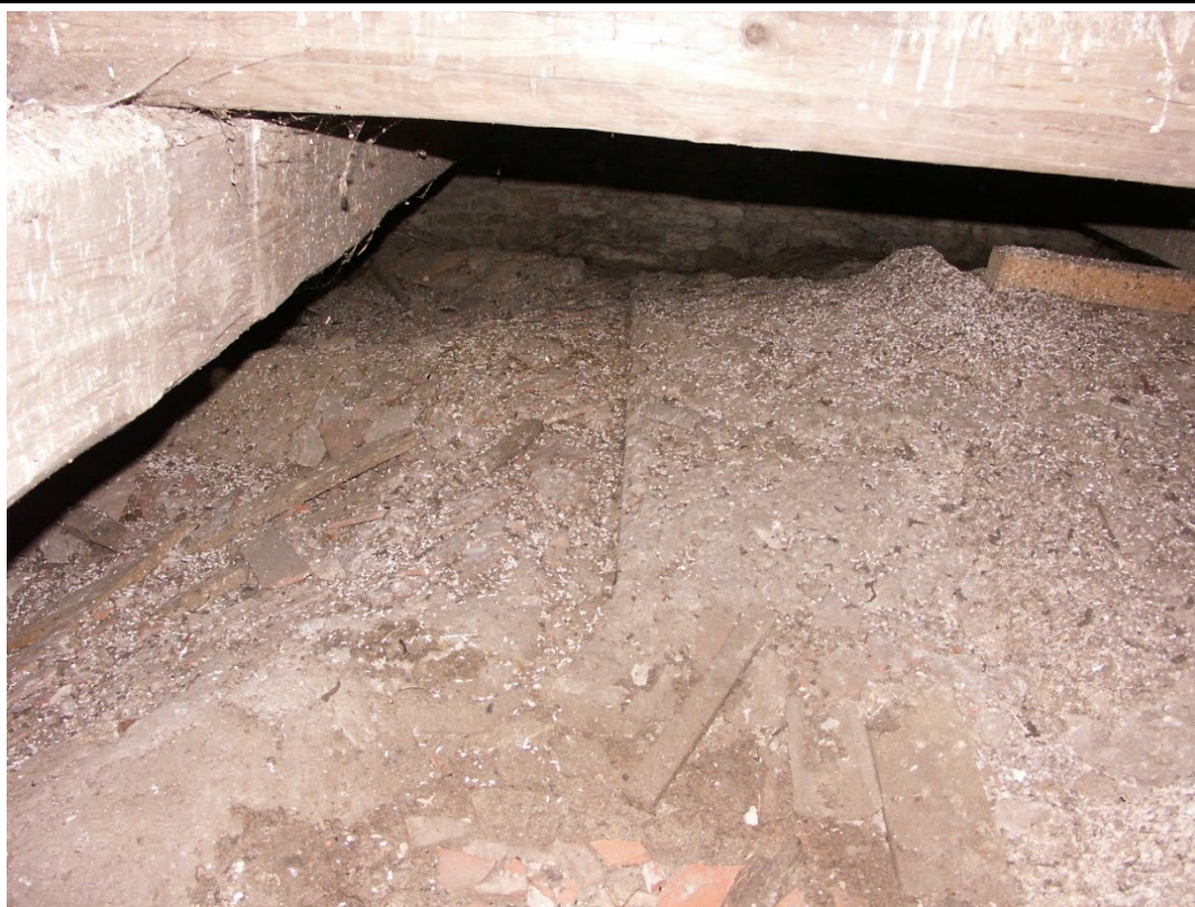
Rubová strana klenby presbytáře se zřetelným zářezem do zdiva, který vznikl obezděním později zaniklého vazného trámu středověkého krovu. Foto: Jaroslav Skopec, 2009.
