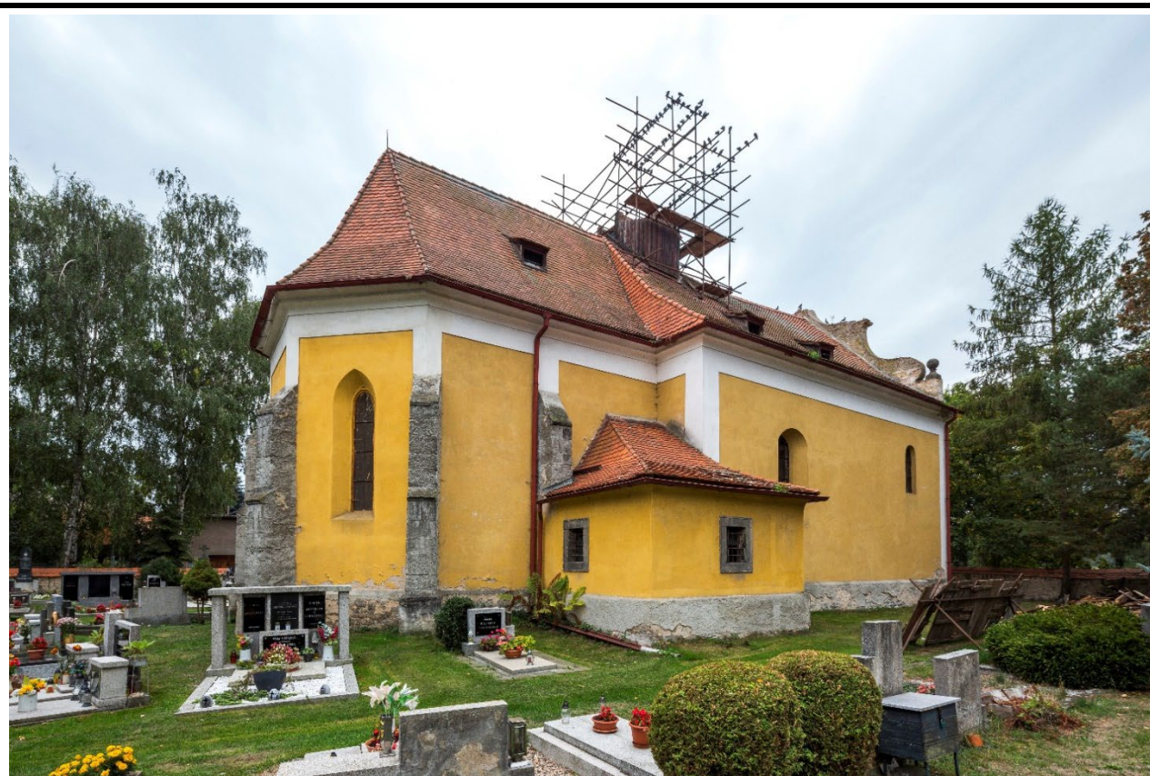
Celkový pohled od severovýchodu. Foto: Marta Pavlíková, 2018.
