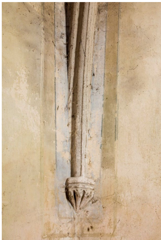
Severoseverovýchodní konzole a klenební výběh v pohledu od jihovýchodu. Foto: Marta Pavlíková, 2018.
