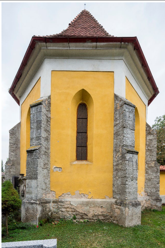
Východní strana závěru presbytáře v pohledu od východu. Foto: Marta Pavlíková, 2018.
