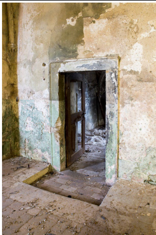
Portál do sakristie v pohledu od jihovýchodu. Foto: Marta Pavlíková, 2018.
